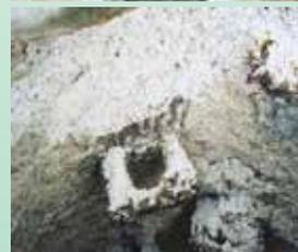
Hormigón problema de corrosión y oxidación. fácilmente se crean depósitos (El hormigón es material poroso).
